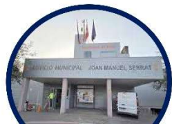
EDIFICIO MUNICIPAL "JOAN MANUEL SERRAT"
